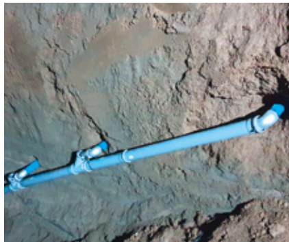
Teilsickerrohre in horizontaler Ausrichtung dienen dem Fassen des Sickerwassers.
