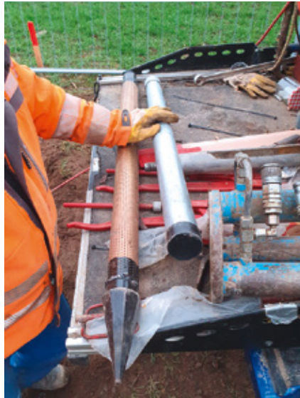
Rammfilter für die Grundwassermessstelle
