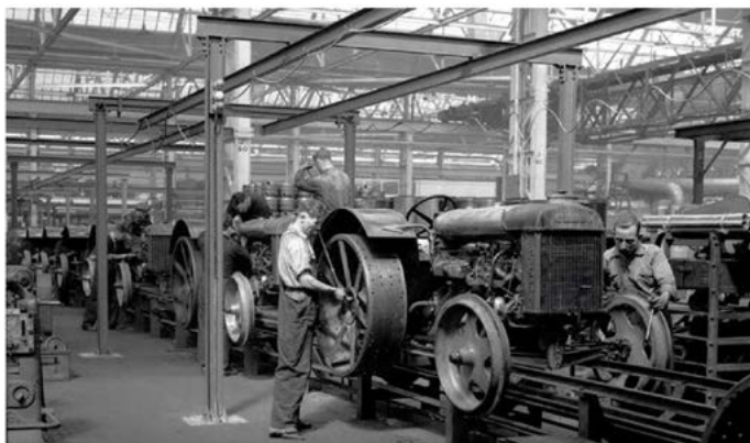
Abbildung: Ford kann seinen Fordson durch serielle Herstellung und einfache Bauweise preiswert anbieten (© Ford-Werke GmbH) (Quelle: Bild und Text oben: KTBL (2023): 100 Jahre KTBL – eine Chronik. Darmstadt, Kuratorium für Technik und Bauwesen in der Landwirtschaft e. V., S. 8, 16-17)
