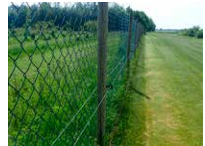
Sichere Einfriedung durch Zaun, der in den Boden eingelassen und außen mit Stromlitzen versehen ist
