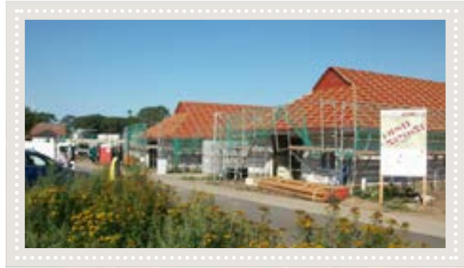
Im Bau befindliche Gebäude des Projekts
