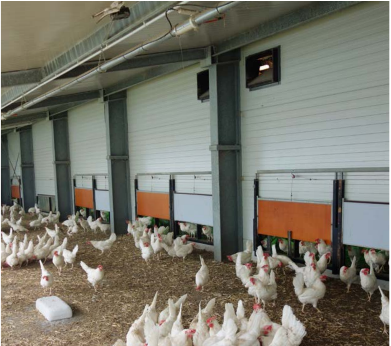
Abb. 56: Automatische Beschäftigung in Form eines Förderrohrsystems mit Auswurföffnungen im Kaltscharraum.
