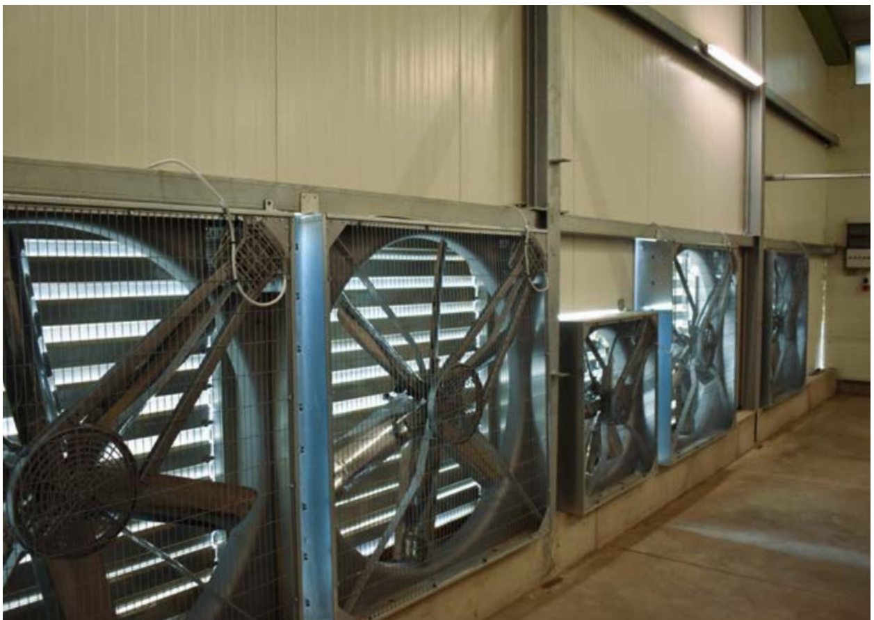
Abb. 81: Beispiel für gut erreichbare Abluftelemente.
