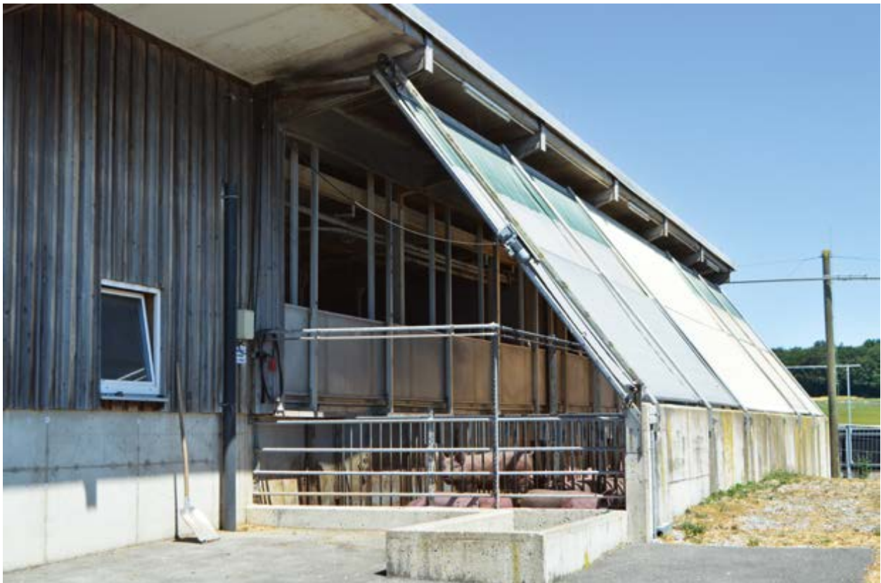
Tiergerechte Außenklimaställe mit freier Lüftung und Auslauf müssen wegen des Immissionsschutzes größere Abstände zur Wohnbebauung und sensiblen Gebieten einhalten.
