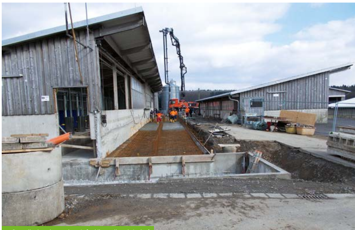
Baustelle eines tiergerechten Außenklimastalles mit Auslauf.
