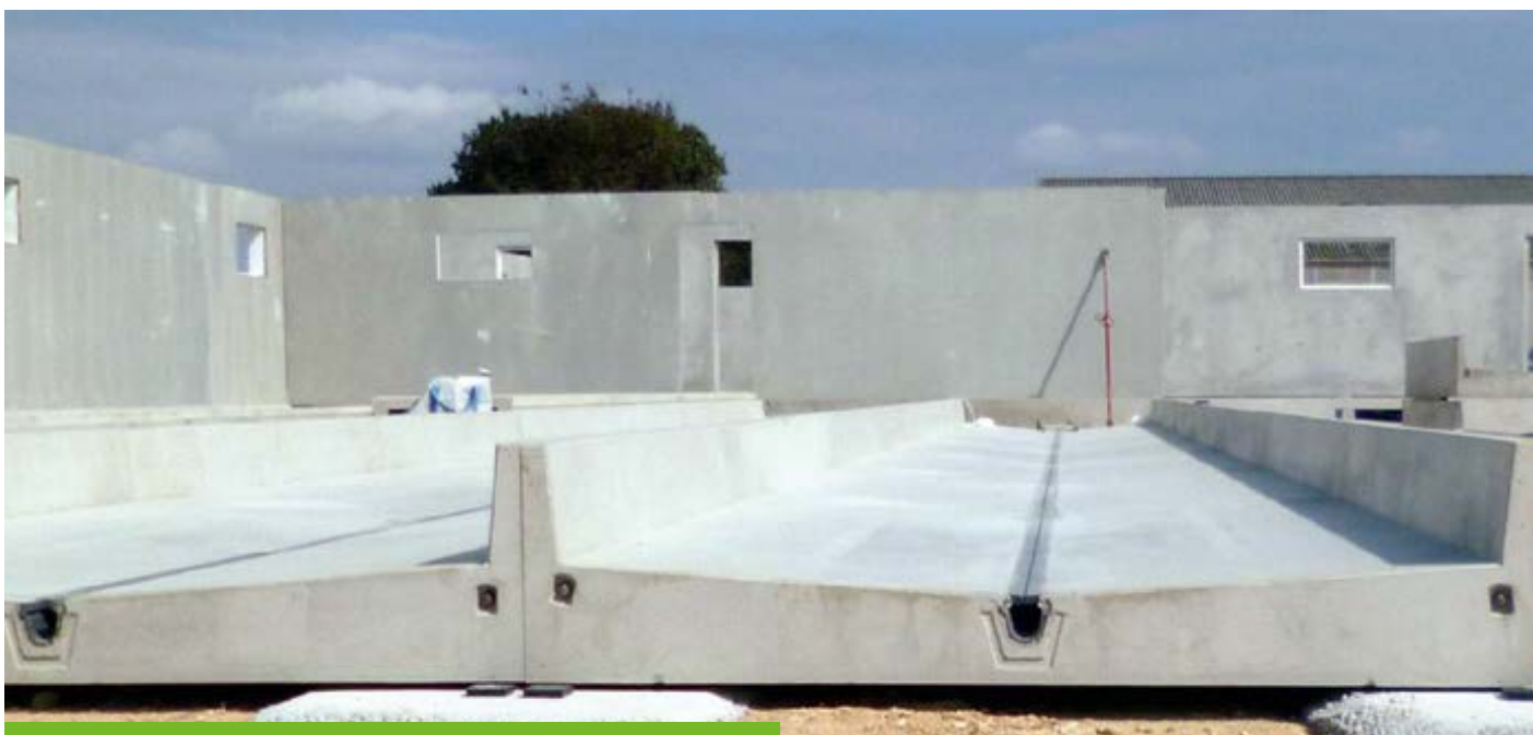
Durch eine Kot-Harn-Trennung kann die Bildung von Ammoniak verringert werden.
