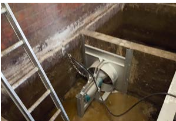
Mit einem Tauchmotorrührwerk können Schwimmdecken sicher aufgebrochen werden.
