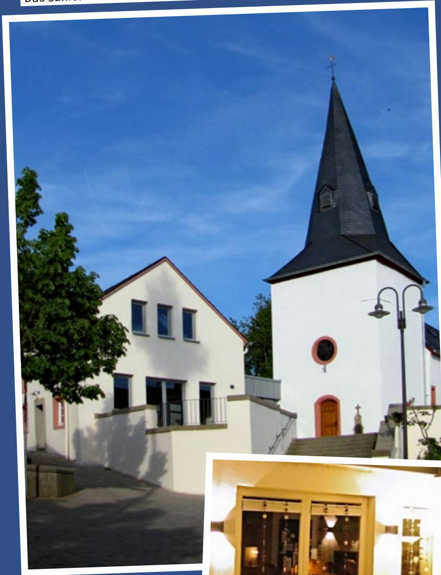
Das sanierte Ensemble im Herzen von Sirzenich
