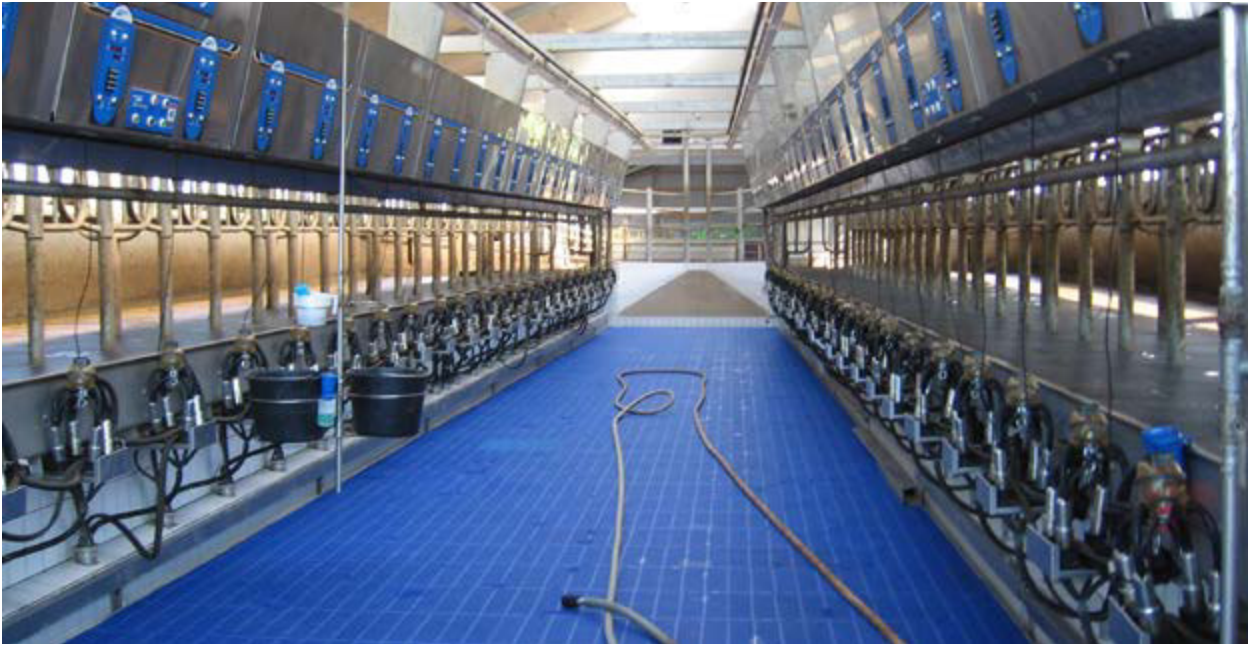
Eine breite Melkgrube benötigt zur richtigen Ausleuchtung der Arbeitsbereiche zwei Leuchtenreihen.
