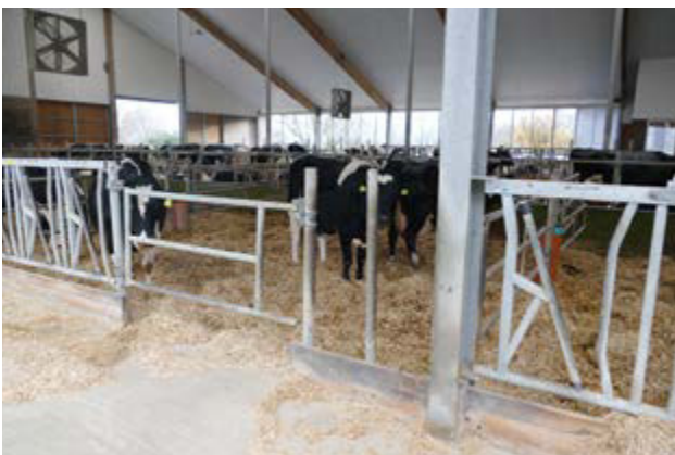
Bei der Frontgestaltung ist darauf zu achten, dass Kühe fixiert und Mensch und Technik schnell in die Gruppe verbracht werden können.
