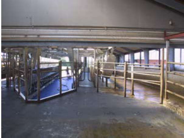
Wartebereich mit zu öffnenden Seitenwänden und einem trichterförmigen Zulauf.
