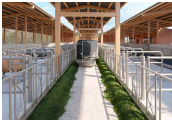
Futtertisch mit Roboter im Kompromissstall.
