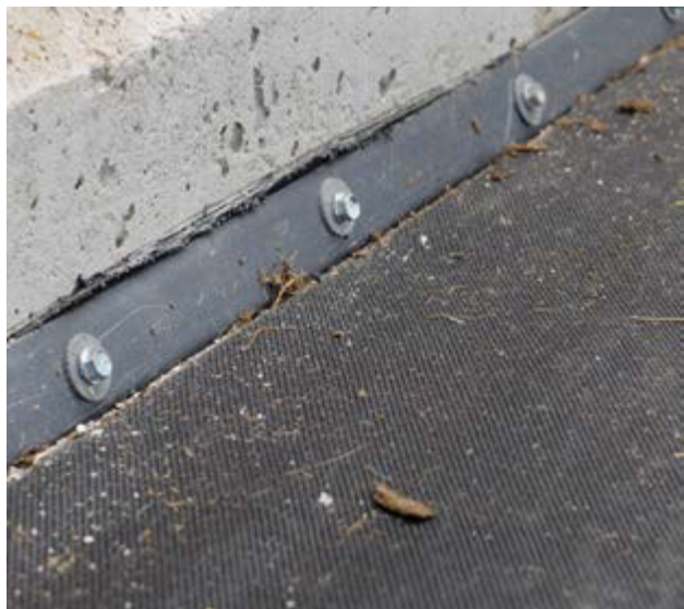
Semipermeable Lauf- und Liegeflächen und semipermeable Matratzen (auch als Nachrüstung für Laufflächen).
