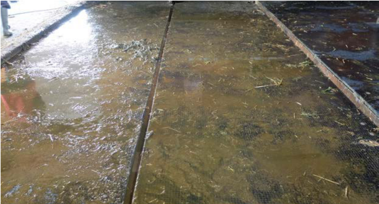
Planbefestigte Lauffläche mit Gummiauflage.
