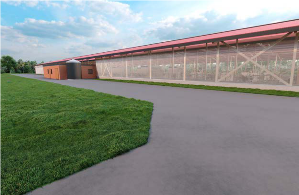
Außenansicht auf den Ökonomiestall.
