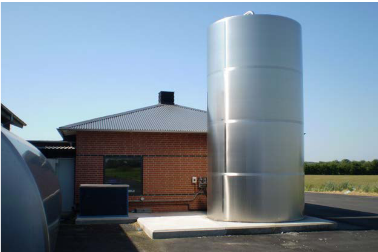
Umwandlung von Energie: Bei der Kühlung der warmen Milch wird im Gegenstrom Wasser für die Reinigung erwärmt.
