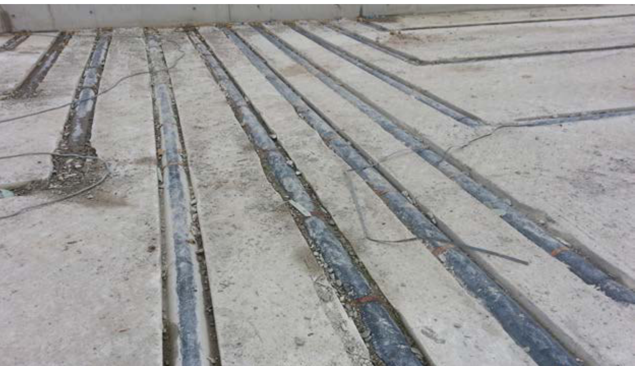
Die Belüftungsrohre befinden sich unter der Kompostmatte.
