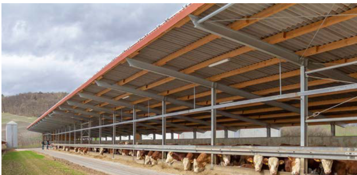
Einschichtiger Dachaufbau mit Trapezblechen.
