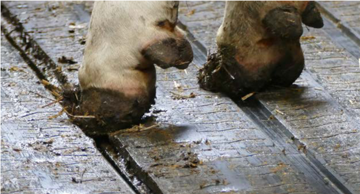
Planbefestigte Lauffläche mit emissionsreduzierender Gummiauflage.
