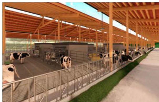
Blick auf den befahrbaren Futtertisch im Ökonomiestall.
