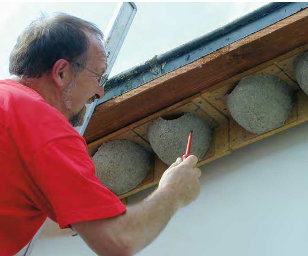
Montage von gekauften Schwalbennestern, die an einem Brett befestigt sind.
