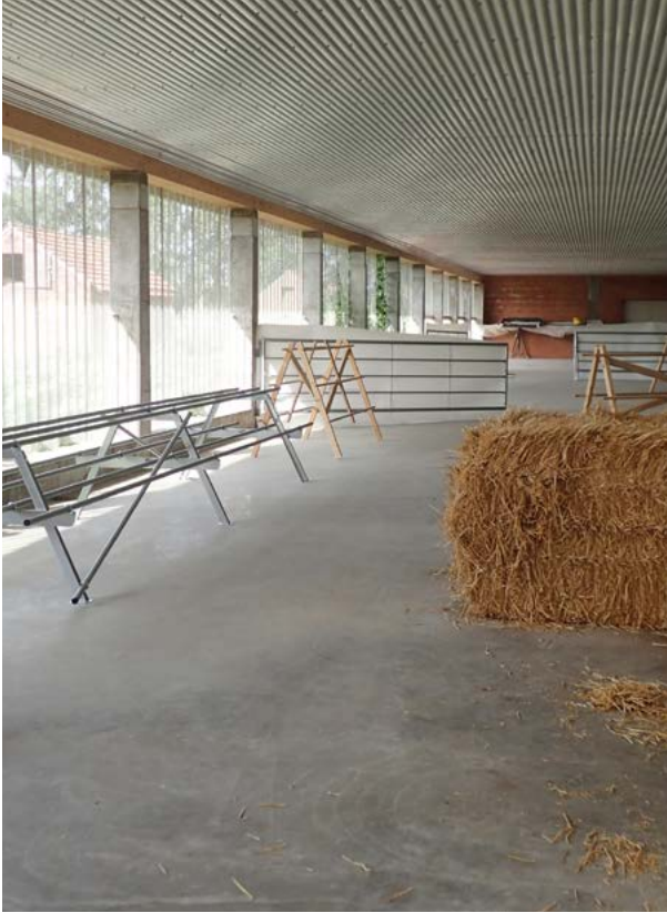
Außenklimabereich beim Einrichten.
