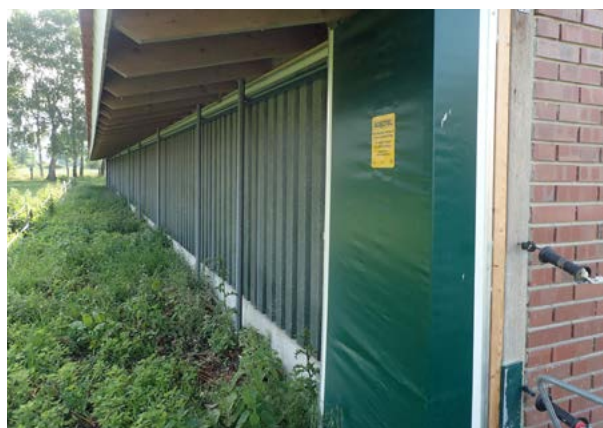
Außenklimabereich mit Verdunkelungsmöglichkeit.
