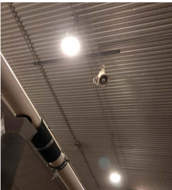
Beispiel für einen verbauten Lautsprecher.
