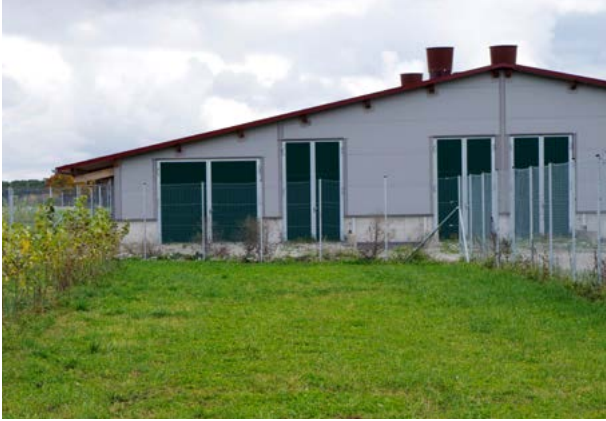
Junghennenstall mit Außenklimabereich und nachgelagertem Vordach.
