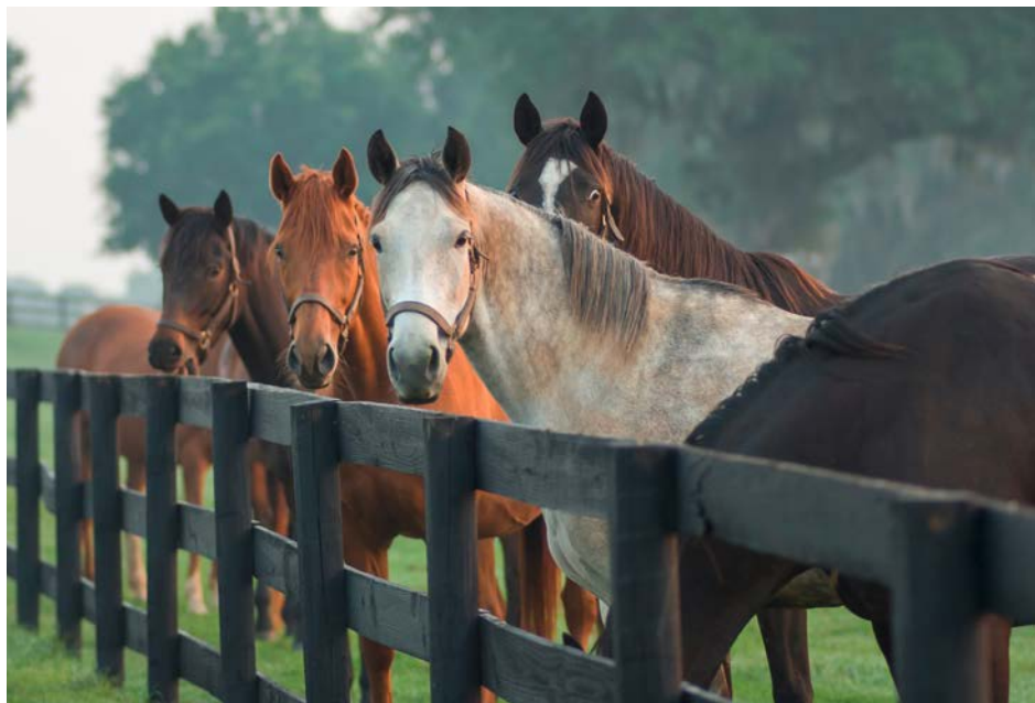
Ein Stabilzaun aus Holz mit drei Querriegeln.
