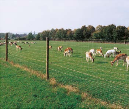
Knotengitter für Wildgehege mit nach innen vorgesetztem Elektrodraht.
