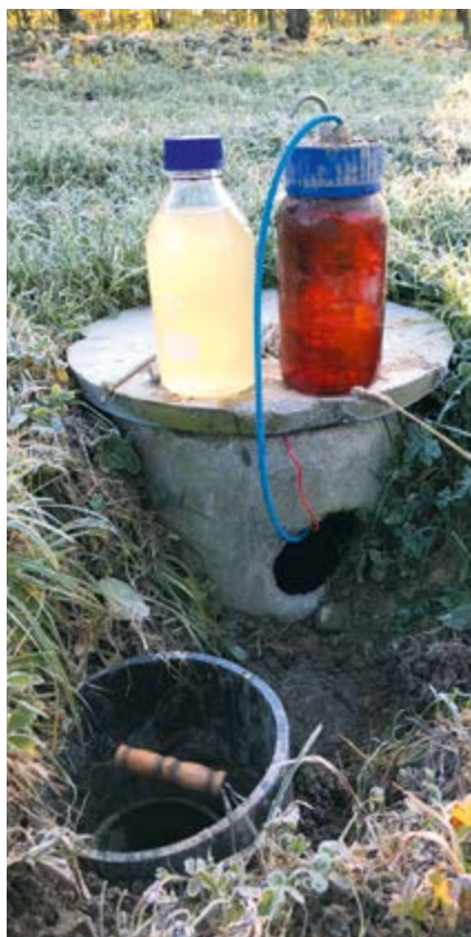
Messstelle in einem Drainageschacht
