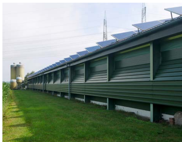
Photovoltaik-Anlage auf einem Stall.
