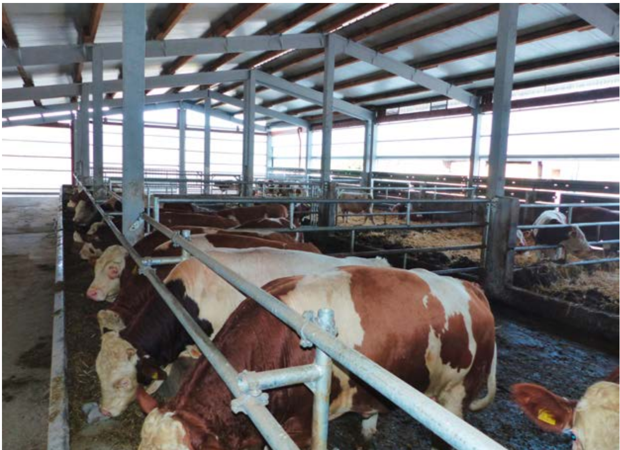
Abbildung 65: Umgebauter Anbindestall zur Fresseraufzucht und Bullenmast als Zweiflächenbucht der ITW-Haltungsform 3 mit Option auf Haltungsform 4.
